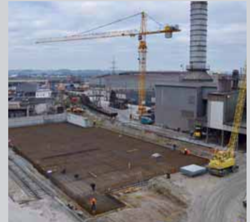
7 – Die Bewehrung der Bodenplatte wird verlegt
