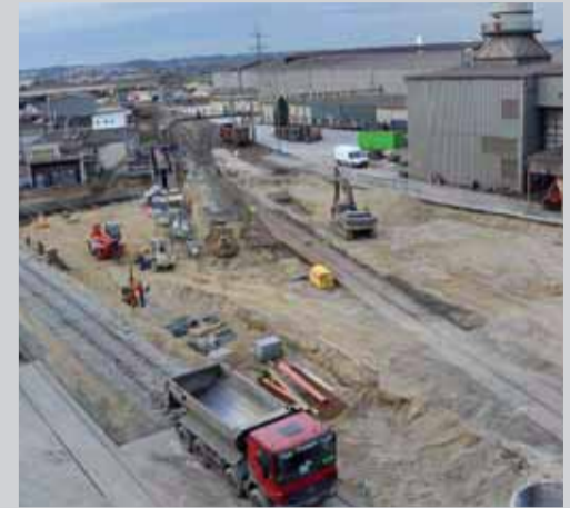
6 – Am Anfang steht der Aushub
