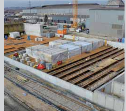
9 – Der Rohbau wächst ständig weiter
