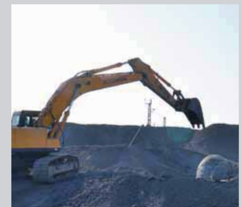
4 – Schlackenhandling im Interimsbetrieb bei MAH
