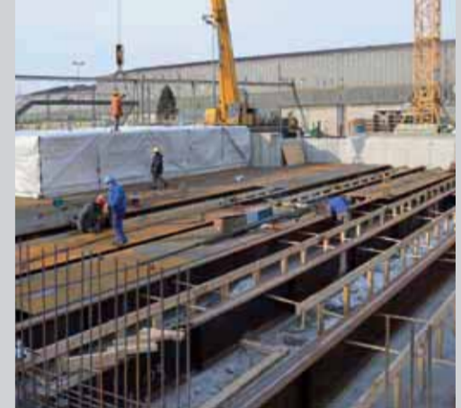
8 – Das Fundament des Überwachungsraums entsteht
