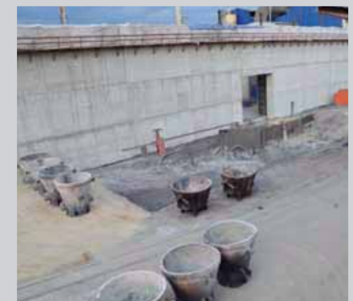
2 – Schlackenkübel vor dem Einsatz
