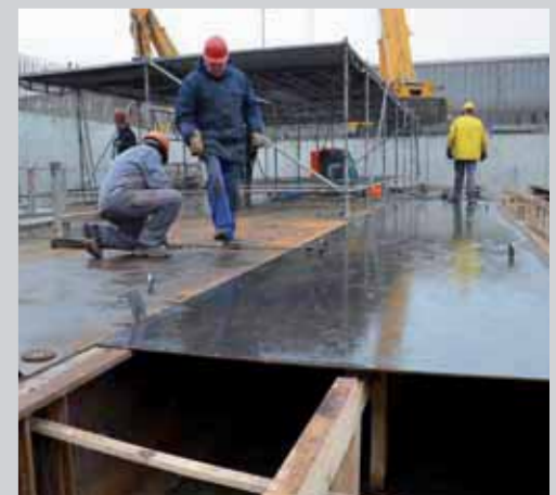
10 – Die Stahlwanne wird verschweißt
