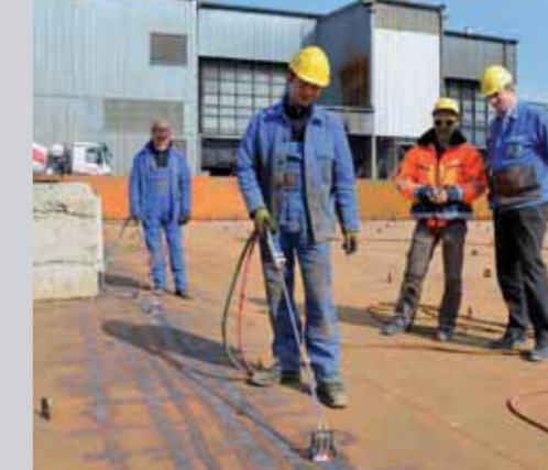
11 – Flammrichter ebnen die riesige Stahlwanne
