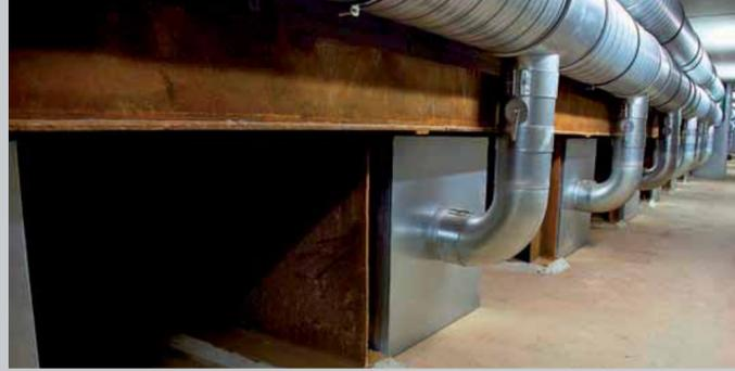
17 – Der belüftete Gang unter der Anlage bietet Zugang zum innovativen Unterflur-Kontroll- und Wartungskammer-System
