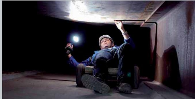
18 – Durch das Unterflur-Kammersystem kann jederzeit der 6-schichtige Sicherheitsaufbau auf Dichtigkeit geprüft werden
