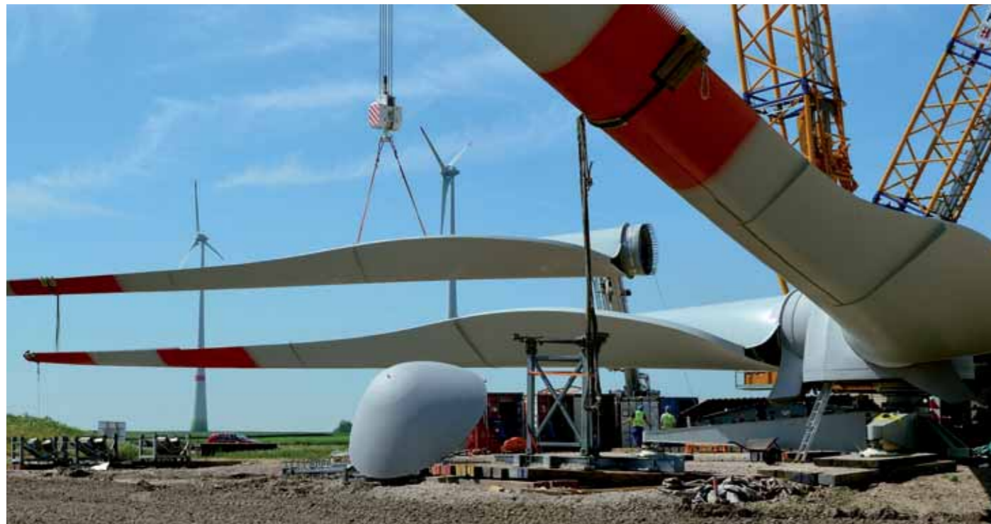
Bei heutigen Windkraftträdern werden in der Regel drei Rotorblätter eingesetzt, die noch am Boden mit der Nabe verschraubt werden.
