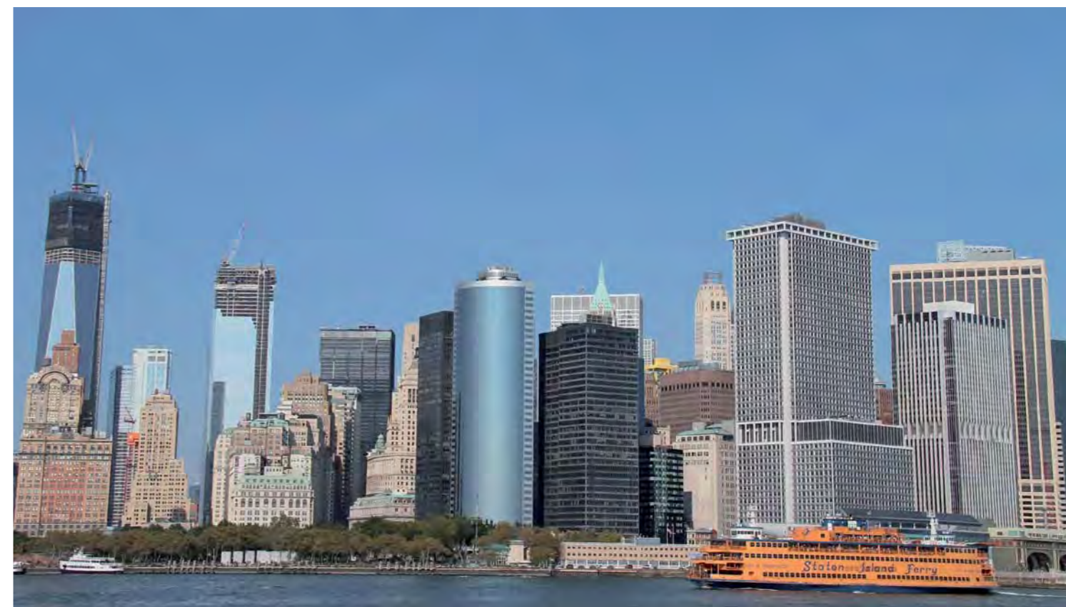
Die neue Skyline von New York – gebaut mit Stahl aus Bayern.
