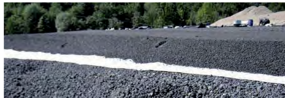
Einbau von EloMinit im Deponiebau: unten die etwas grobkörnigere Gasentspannungsschicht aus EloMinit 16/80, die durch eine geotextile Trennschicht (weiß) von der feinkörnigen Ausgleichsschicht aus EloMinit 0/16 (oben) getrennt ist. Dies bildet die Grundlage zur Verlegung einer mindestens 2,5 mm starken Kunststoffdichtungsbahn, welche auf einer geosynthetischen Tondichtungsbahn (sog. Bentonitmatte) verlegt wird.
