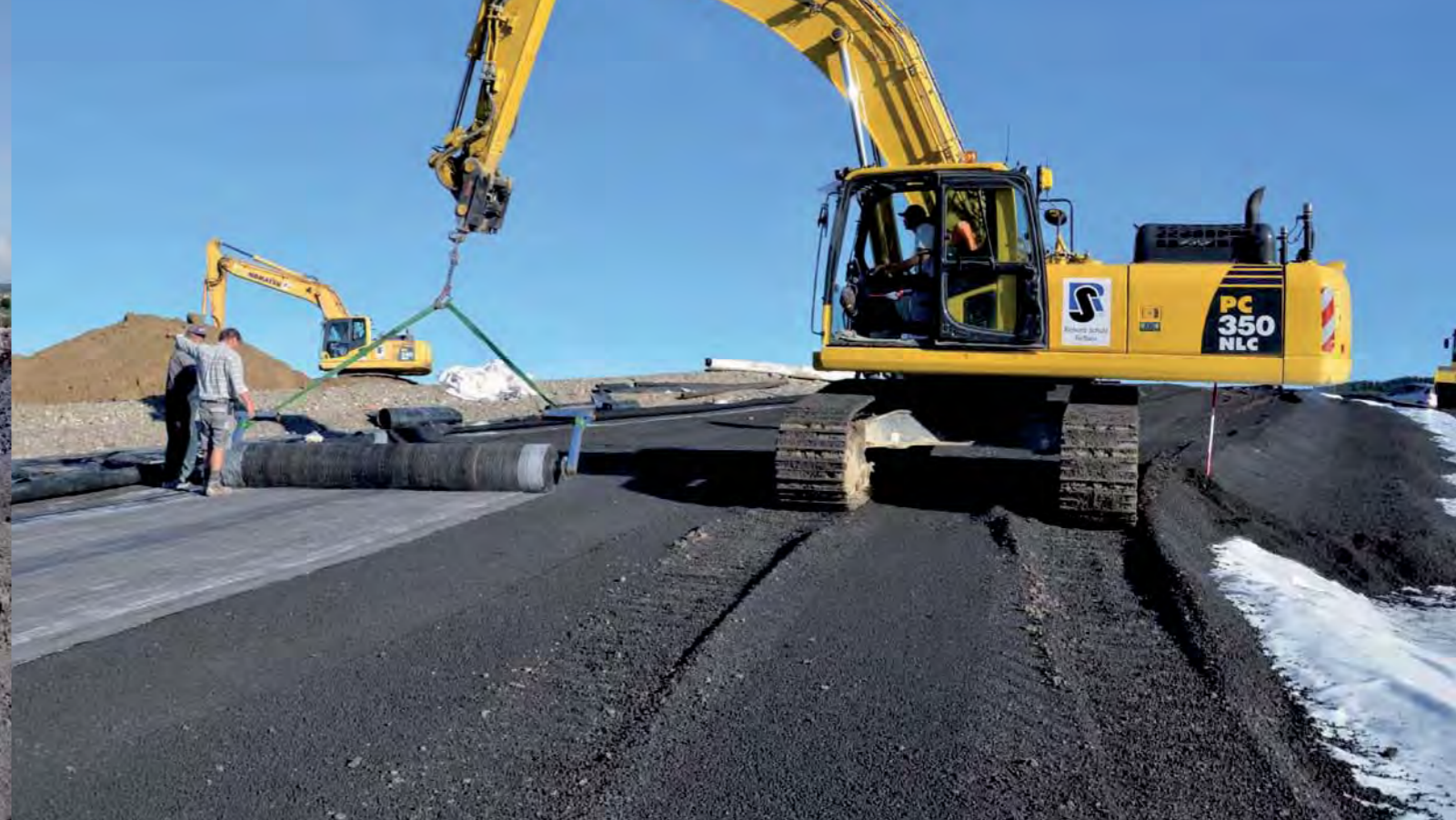
Verlegung der Bentonitmatte auf dem fertiggestellten Unterbau aus EloMinit als Basis für die Kunststoffdichtungsbahn.
