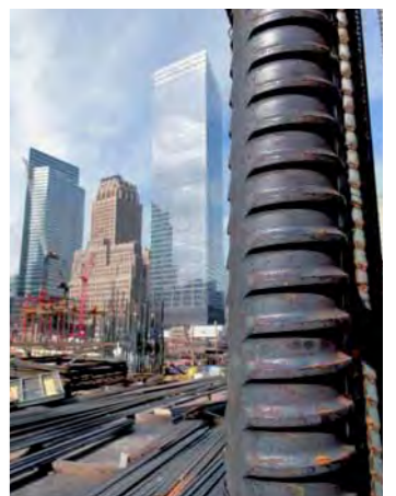
In New York wird seit 2006 am One World Trade Center gebaut. Dabei wird Gewindestahl der Annahütte verwendet. Der Stahl selbst stammt von den Lech-Stahlwerken in Meitingen.
