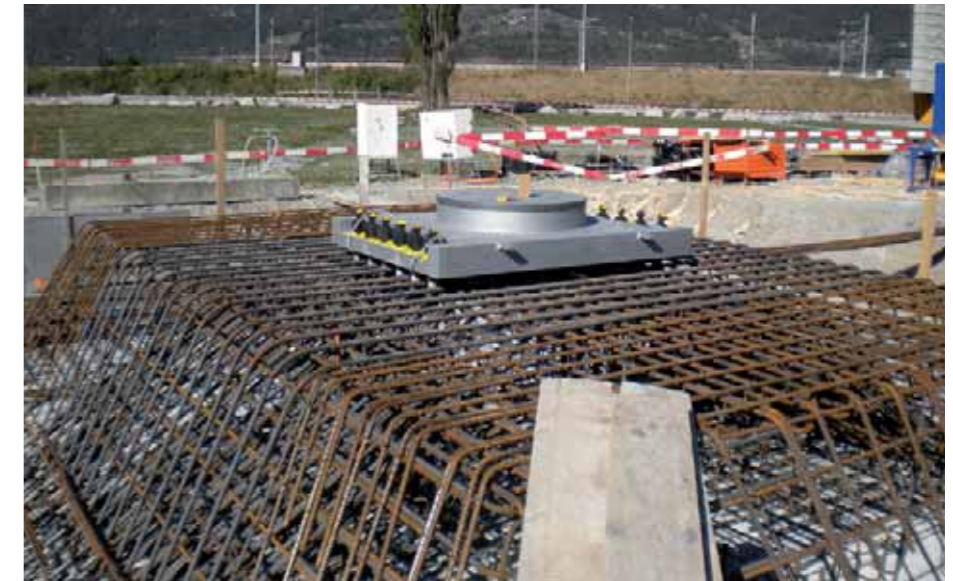
Topflager mit Spanngliedern vor dem Betonieren
