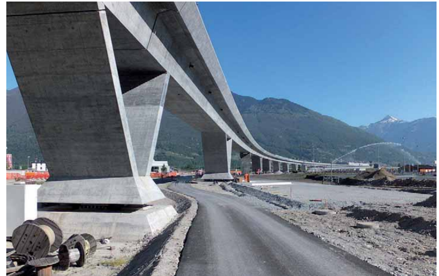
Ansicht am nördlichen Ende des Ceneri-Basistunnels
