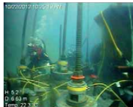
Vorspannen der SAS Felsanker an Fundamentblöcken zur Lagesicherung der Costa Concordia
