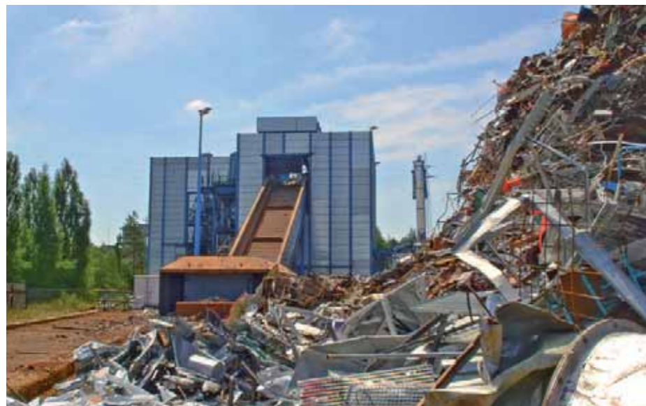
Schredderanlage am Standort Nürnberg
