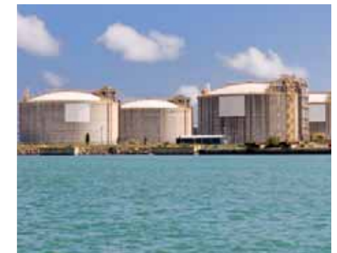
LNG Tanks für die Lagerung von Flüssigerdgas
